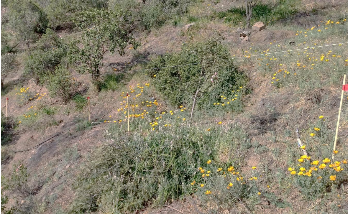
Figura 5. Se observa pitilla plástica blanca delimitando un sector de trabajo, y marcas de ubicación de salidas de agua habilitadas con coligue y cinta roja en forma de bandera.
